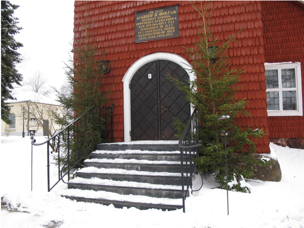
Entré med räcke och portar från restaureringen 1953.
